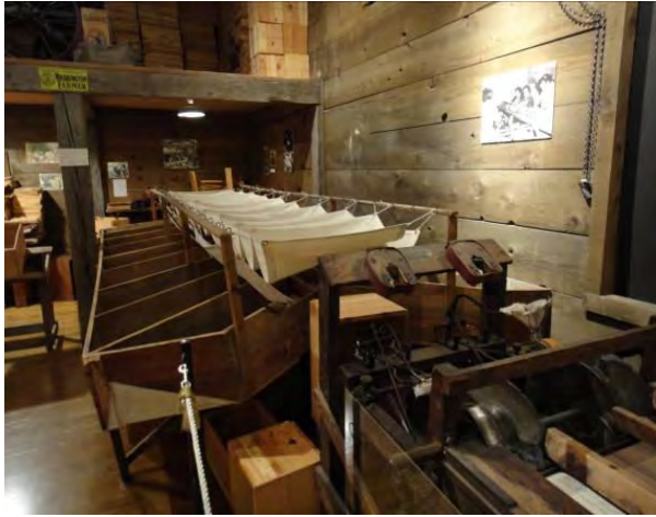
图 15-29 1914 年利用弹力原理建造的选果设备（每天可选 15 吨）
